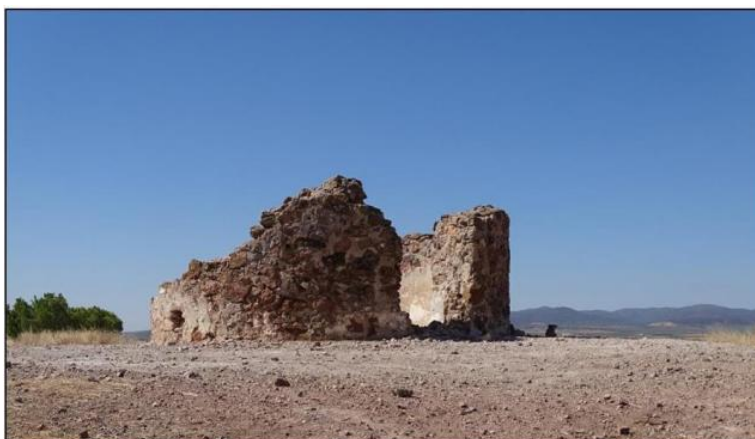
Ruinas de molino de viento en la cresta del Cerro de San Cristóbal Fotografía de Luis M. Román
