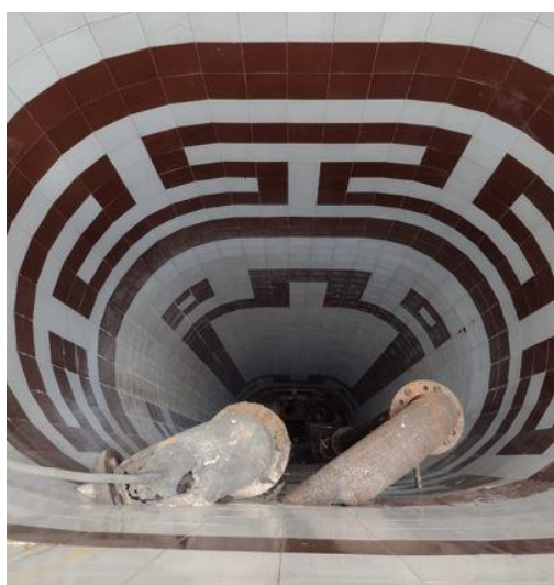
Imagen del pozo primitivo, su profundidad era de 28 metros y la lámina de agua se mantenía estable en torno a los 23 metros
