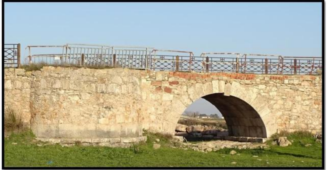
Estado del Puente de San Benito, enero 2020. Fotografía de Luis M. Román.
