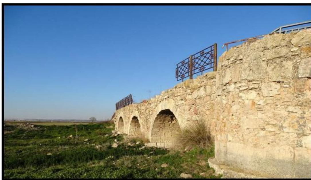
Estado del Puente de San Benito, enero 2020. Fotografía de Luis M. Román.
